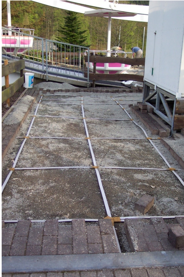
Bild 44 + 45: Potentialsteuerung im Bereich von Fahrgeschäften, z. B. Freizeitparks
