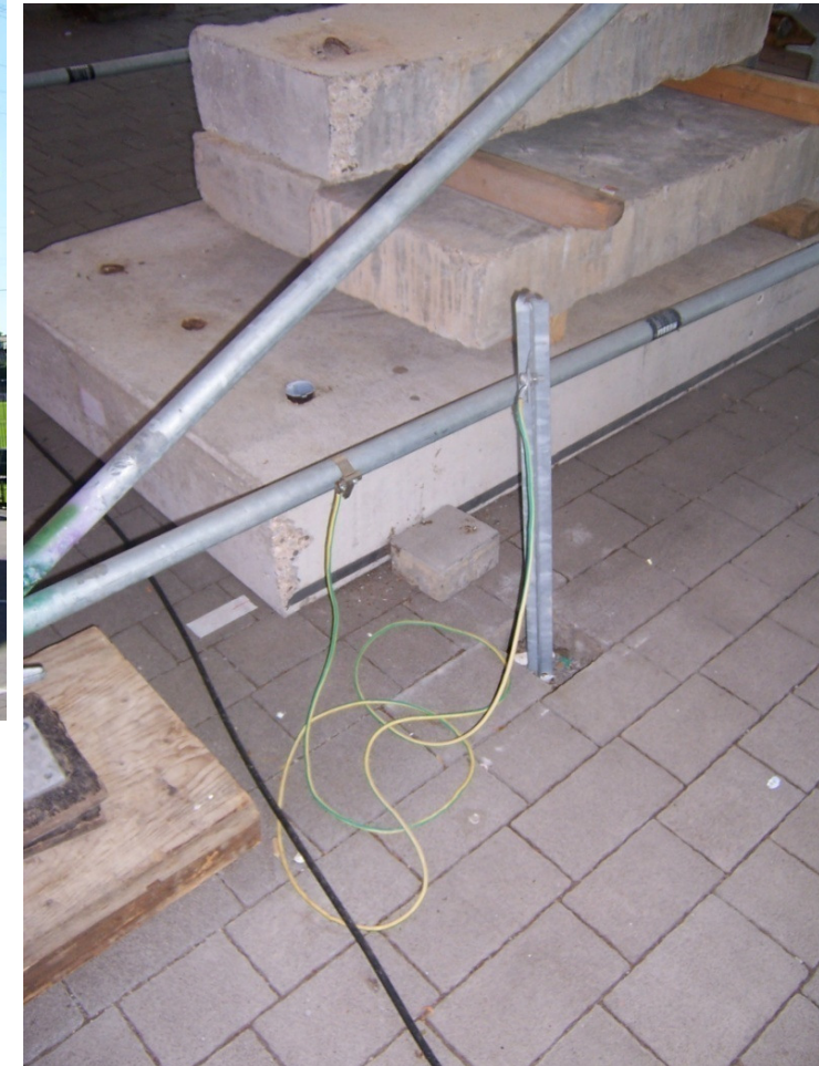
Bild 15 + 16: Unzureichende Erdungsmaßnahmen an einer Stahltribüne mit fehlender Potential- steuerung
