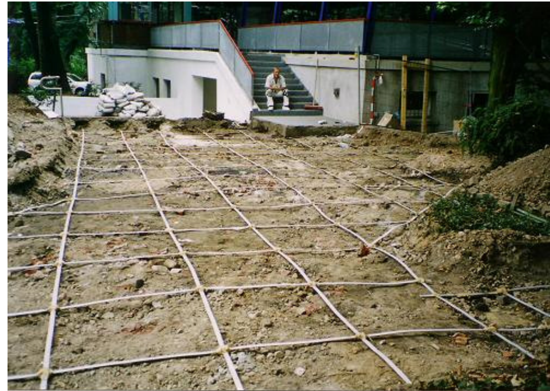
Bild 44 + 45: Potentialsteuerung im Bereich von Fahrgeschäften, z. B. Freizeitparks
