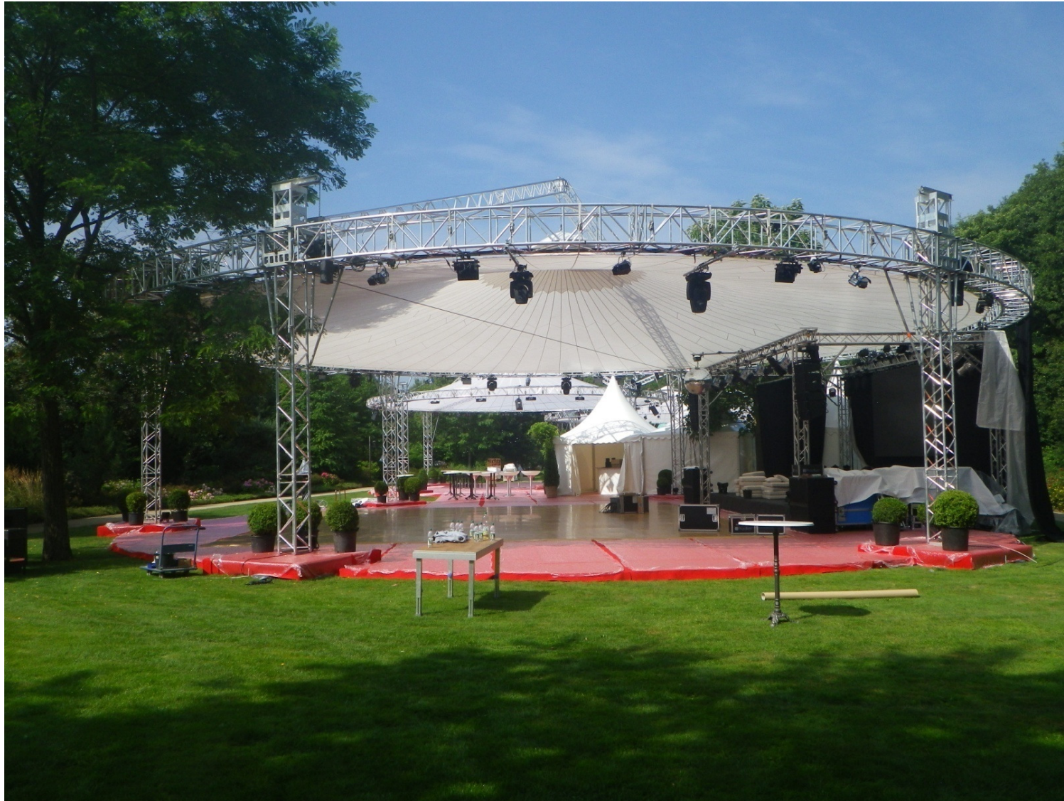
Bild 26 - 28: Maßnahmen der Potentialsteuerung für Veranstaltungsbühnen mittels blitzstromtrag- fähiger Erdung der me- tallenen Konstruktionen und Absteuerung durch Tiefenerder
