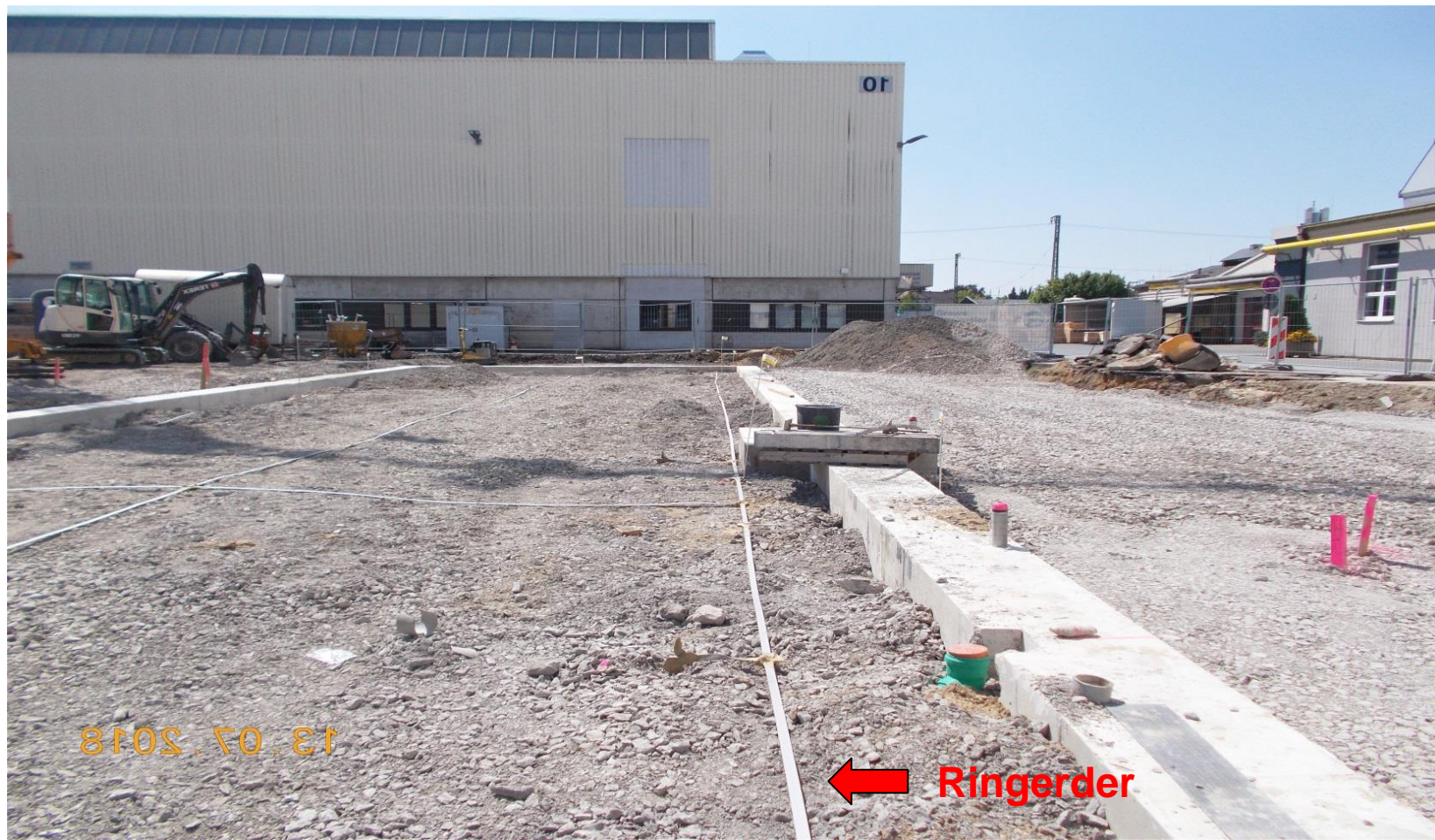
Lösung: Installation eines Ringerders auf der Schotter-schicht
