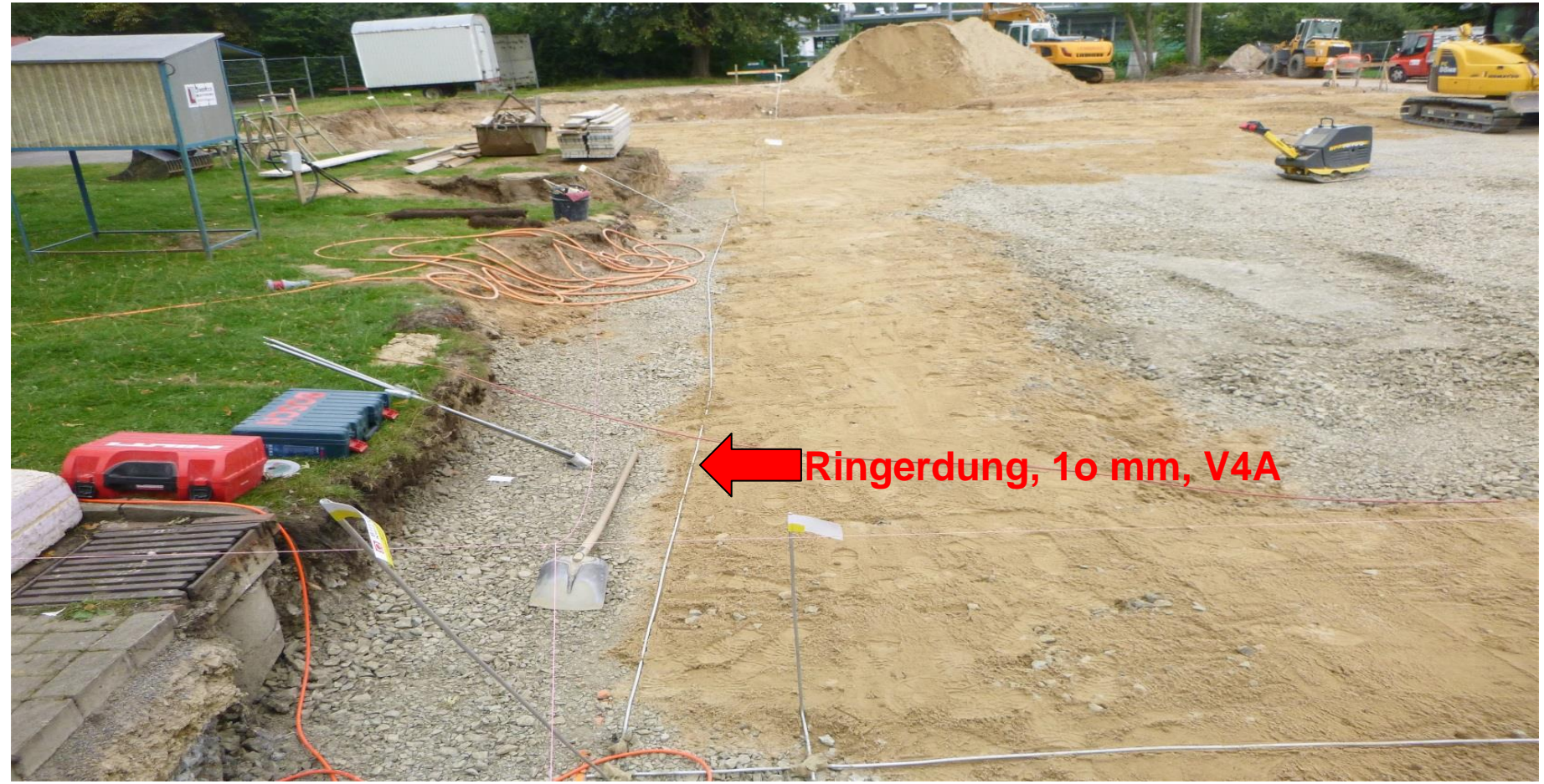
Lösung: Installation eines V4A-Edelstahl-Ringerders auf den Schotterschichten
