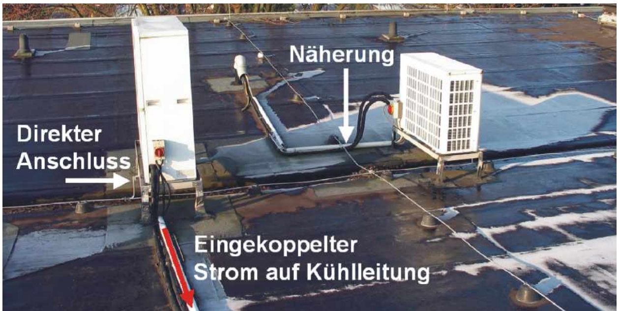
Bild 13: Näherung zwischen Fangeinrichtung und metallenen Dachaufbauten
