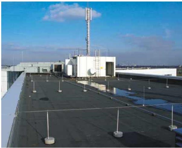
Bild 17: Schutz von metallenen Dachaufbauten und elektrischen Einrichtungen nach dem Blitzkugelverfahren
