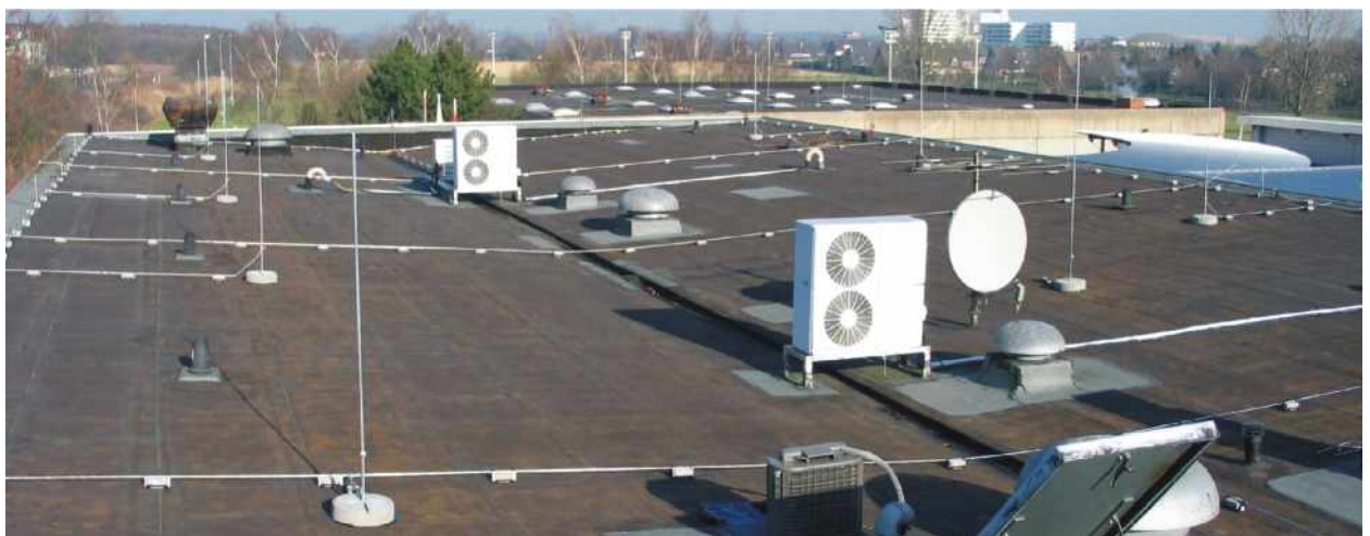
Bild 14: Anordnung der Fangeinrichtungen nach dem Blitzkugelverfahren
