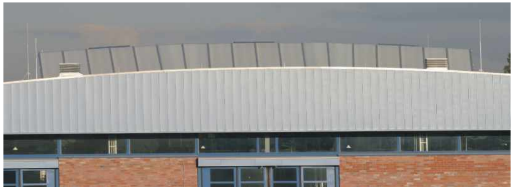
Bild 17: Schutz von metallenen Dachaufbauten und elektrischen Einrichtungen nach dem Blitzkugelverfahren
