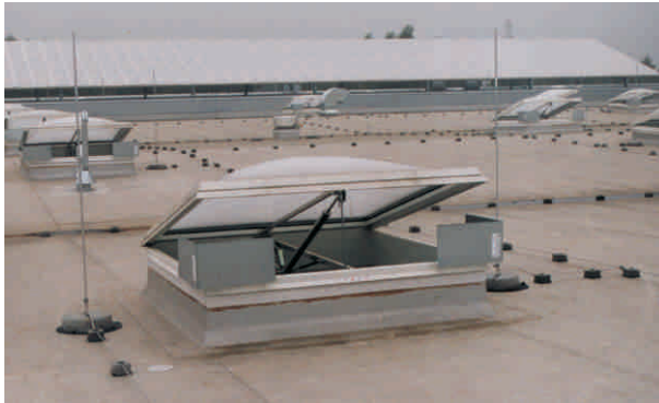
Bild 1: Fangstangen zum Schutz von RWA-Anlagen
