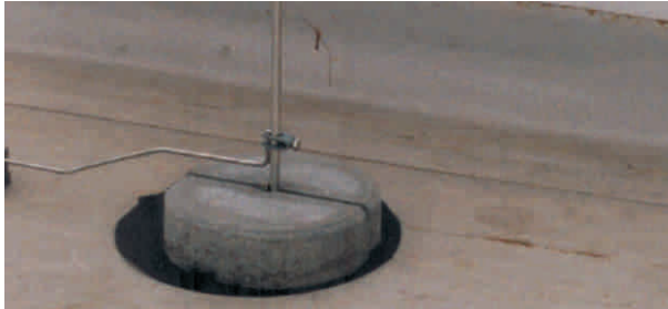
Bild 5: Fangstangen, Befestigung mit Keilklemme
