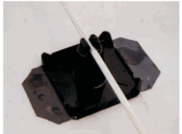
Bild 3: Klebestütze auf Dachabdichtung aus Kunststoffbahn
