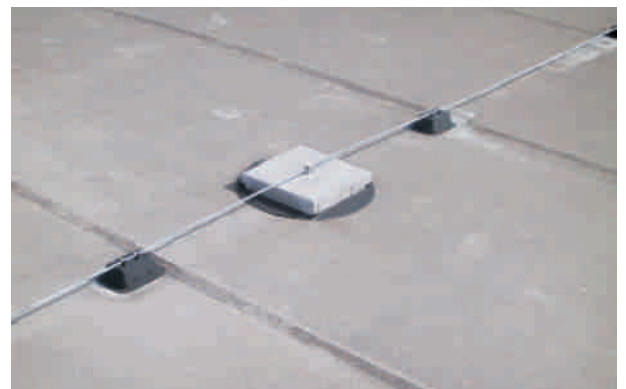
Bild 4: Lagefixierung der Fangleitung durch zusätzlichen Betonstandfuß
