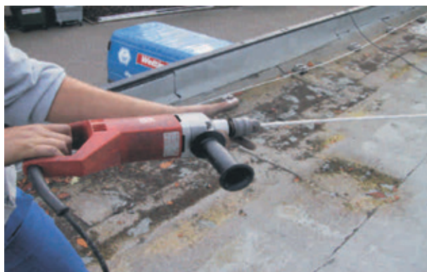
Bild 1: Richten von Aluminiumdraht mit der Bohrmaschine
