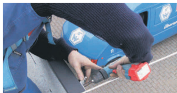
Bild 3: Montage eines Aluminiumwinkels mit Hilfe eines Akkuschaubers
