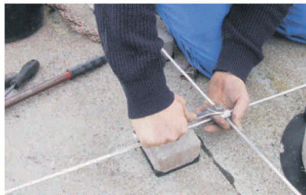
Bild 4: Montage einer Verbindungsklemme mit Hilfe eines Maulschlüssels
