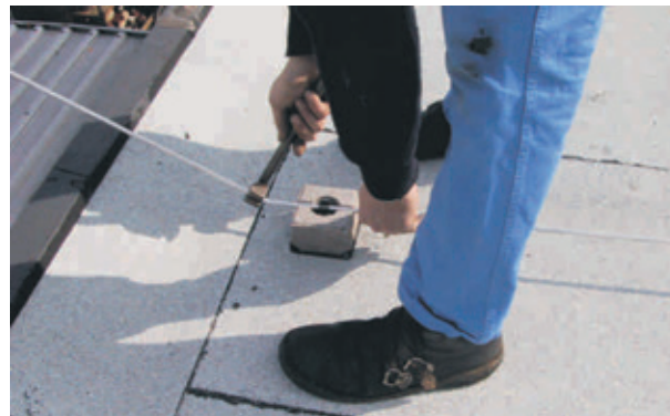
Bild 2: Montage mit Biegeisen
