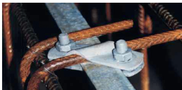
Bild 5: Klemmverbindung zwischen Fundamenterder und Bewehrung mit einem Diagonalverbinder
