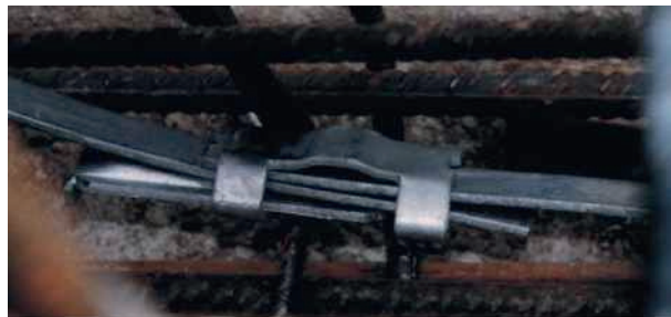
Bild 3: Zwischen die Kontaktflächen kann Beton eindringen
