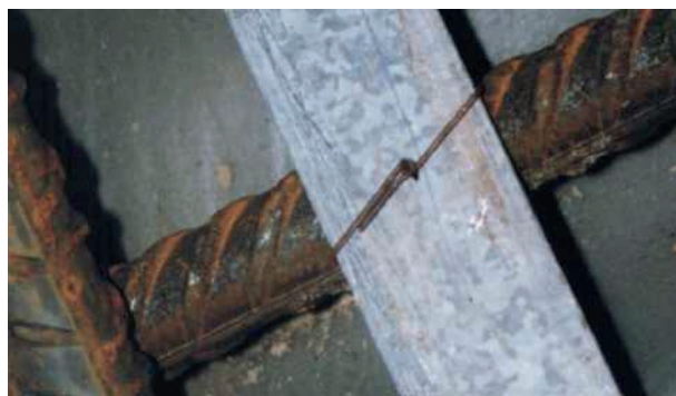
Bild 4: Fundamenterder durch eine Rödlerverbindung mit der Bewehrung verbunden
