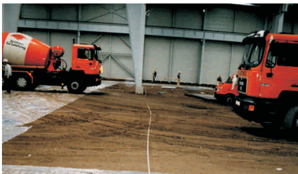
Bild 2: Montage der Erdungsleitung, Flachband 30 * 3,5 mm, V4A, Werkstoff-Nr. 1.4571
