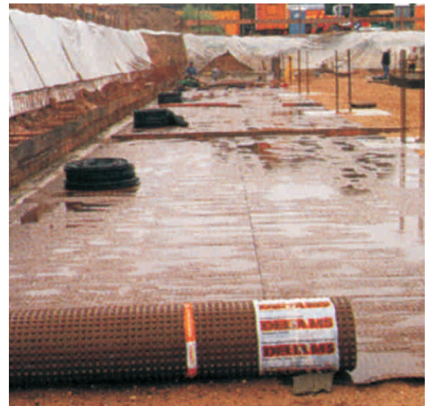
Bild 1: Kunststoffnoppenbahn als Ersatz für eine Sauberkeitsschicht
