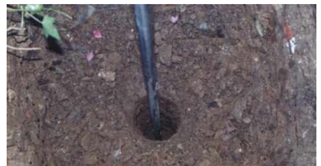
Bild 2: Schachtgrube mit Bohrloch für die Montage von Tiefenerdern
