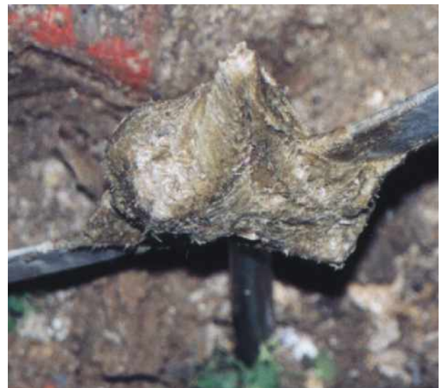
Bild 7: Verbindungsstelle mit Korrosionsschutzbinde
