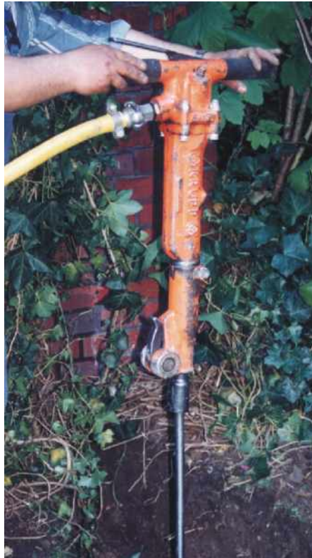
Bild 3: Eintreiben eines Tiefenerders mittels Vibrations- hammer
