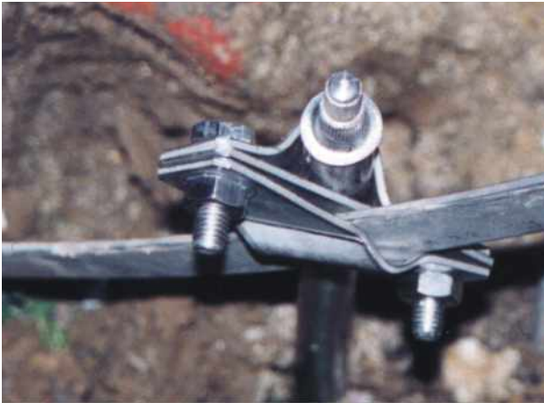
Bild 5: Verbindung zum Tiefenerder
