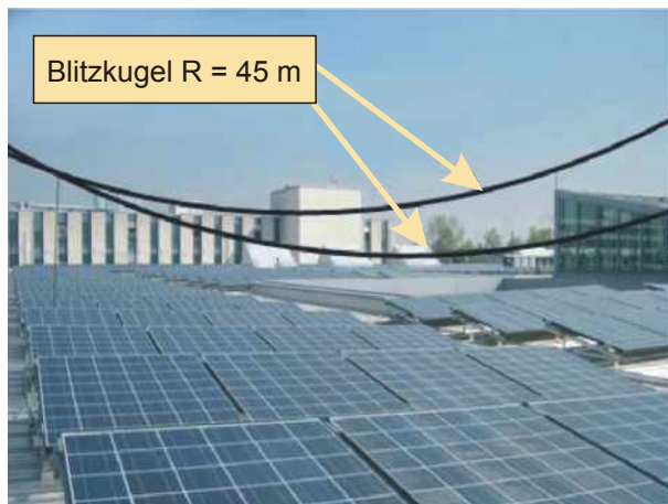
Bild 3. Aufgeständerte kristalline PV-Module auf Metalldach (Objekt im Landkreis München)
